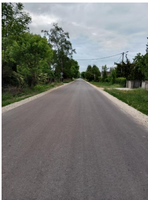
Foto. Przebudowana droga Przyrów - Knieja
