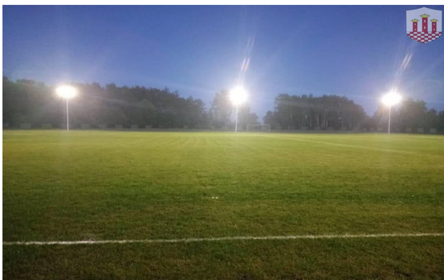
Foto. Oświetlenie ledowe na terenie rekreacyjno-sportowym "Brzózki" w miejscowości Przyrów
