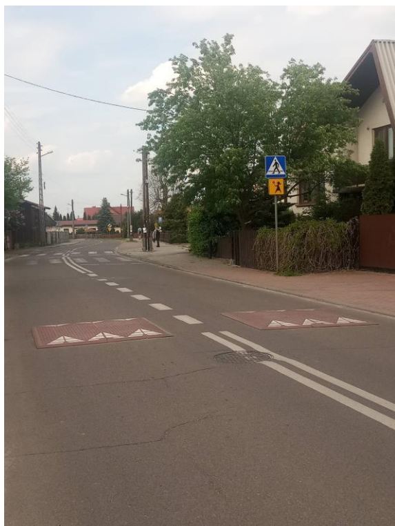
Progi zwalniające na ul. Szkolnej w m. Przylów
